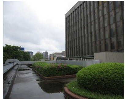
区役所の屋上緑化
