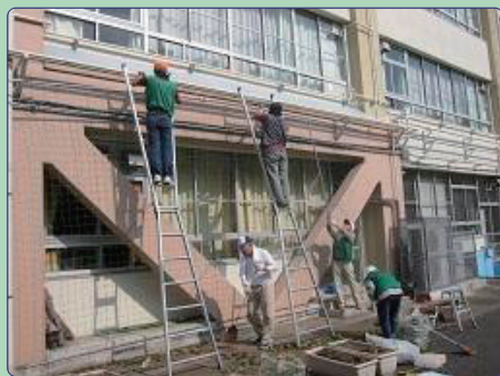
北砂小学校のネット外し
